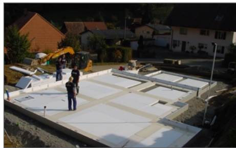
Dämmung verlegen
